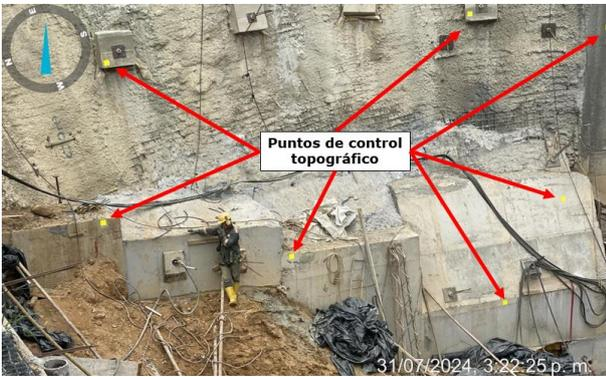
**Figura 19.** Ubicación de los puntos de control topográfico a lo largo de las pantallas.
