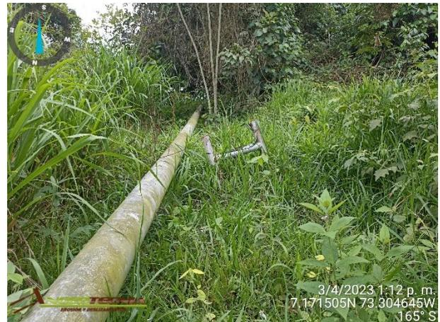
**Figura 8.** Tubería desplazada fuera de los soportes sector La Francia.
