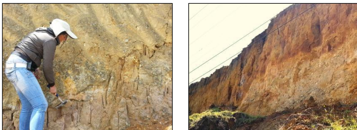
Figura 25. Sitio N° 1. a) Detalle de la degradación diferencial en el pie del talud en un estrato más débil y b) Taludes casi verticales donde se observan la estratigrafía.
